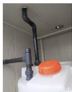
L'evacuazione o l'immissione dell'aria dai serbatoi, durante il riempimento o lo svuotamento, sono assicurate mediante due tubazioni che sfatano all'esterno dei rispettivi comparti della struttura.
